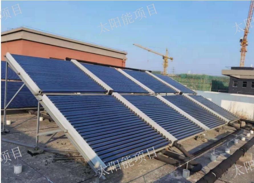
玻璃真空管太阳能热水器太玻璃真空管太阳能可细分为全玻璃真空管式、热管真空管式□U型管真空管式/真空管集热、储热一体化闷晒式。常用的为全玻璃真空管式，其优点：安全、节能、环保、经济。尤其是带辅助电加热功能的太阳能热水器，它以太阳能为主，电能为辅的能源利用方式使太阳能热水器全年全天候正常运行，环境温度低时效率仍然比较高。其缺点在于体积比较庞大、玻璃管易碎、管中容易集结水垢、不能承压运行。在吸热方面，太阳能一次吸热(指直接从阳光获取热能)材料主要有金属、塑料、玻璃等，但实际使用的几乎全是金属。按吸热板芯材料划分有钢板铁管、全铜、全铝、铜铝复合、不锈钢、塑料、溴化锂、氯化锂、硫化钠、硅胶、水等，国内外使用得比较普遍的是全铜集热器和铜铝复合集热器。昆山祥瑞机电设备工程有限公司为您提供太阳能，期待您的光临！江苏酒店太阳能控制器
